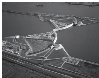
2 - Rotterdam, portes à flot contre les tempêtes
